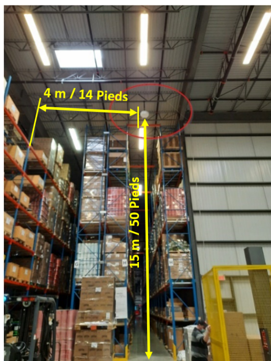
Figure 6. Installation du lecteur RTLS passif
